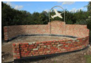
Het monument in aanbouw
